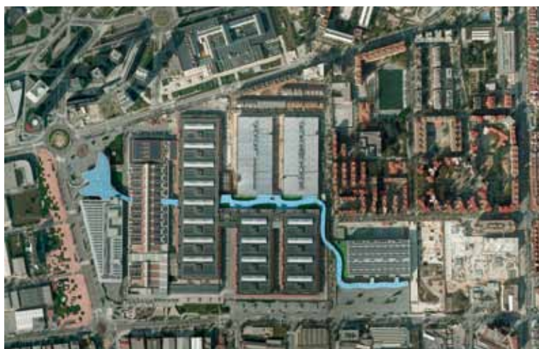
Vista aérea del recinto de Gran Via con los dos nuevos pabellones ya construidos.
